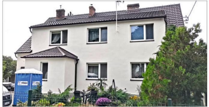
...i w trakcie remontu
