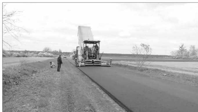
Przebudowa drogi powiatowej Kościuszkowo-Pępowa
