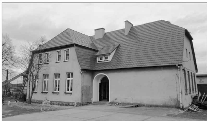
Remont dachu świetlicy wiejskiej w Pasierbach
