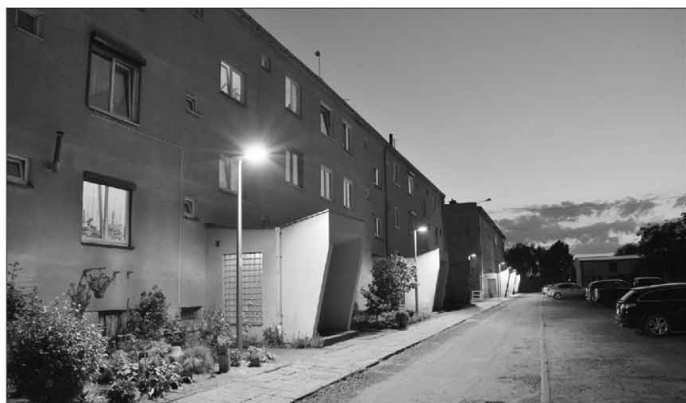
Dobudowa i budowa oświetlenia ulicznego w Pępowie przy ul. 1 Maja w Pępowie.
